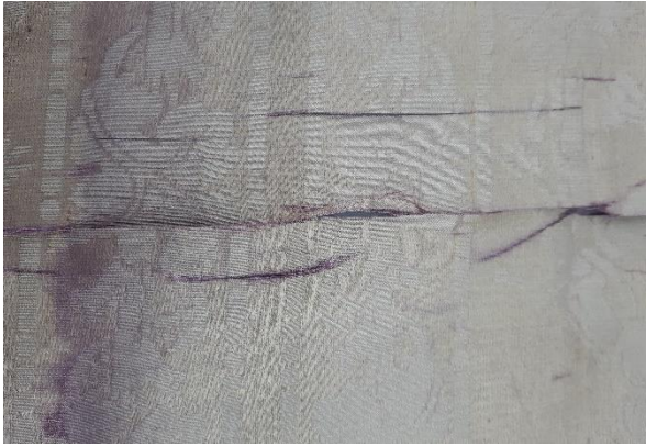
Abb. 30: Durch Zug versetzte Rissstellen
