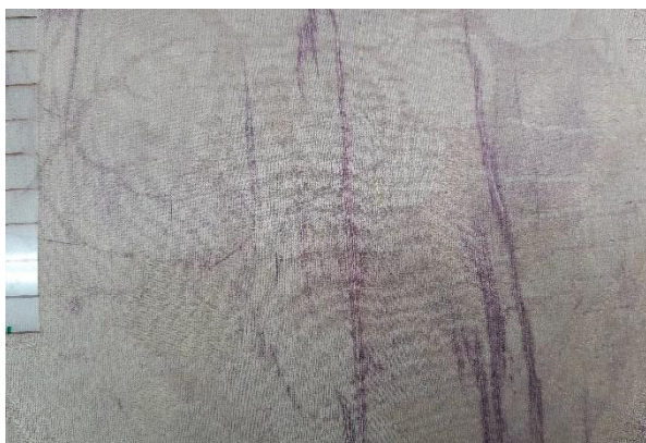
Abb. 59: Fertig gesicherter Bereich
